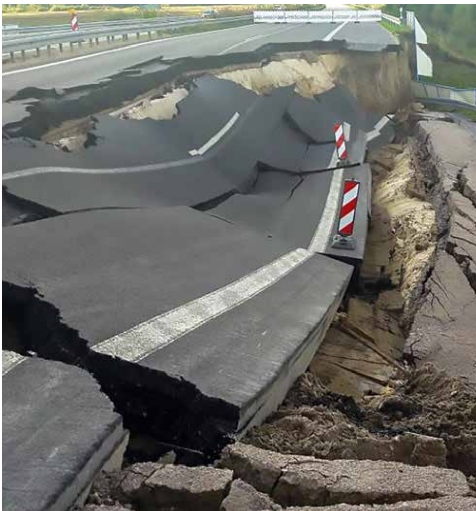
Manchmal geht nichts mehr. Eine wichtige Verbindung ist unterbrochen: Fahrbahnabbruch und Vollsperrung auf der A 20 bei Tribsees.
